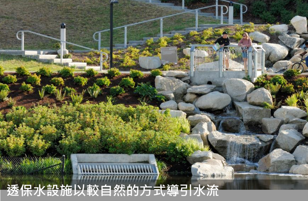
透保水設施除了美化環境，更多的透水面積有助於雨水下滲，降低路面淹水風險
