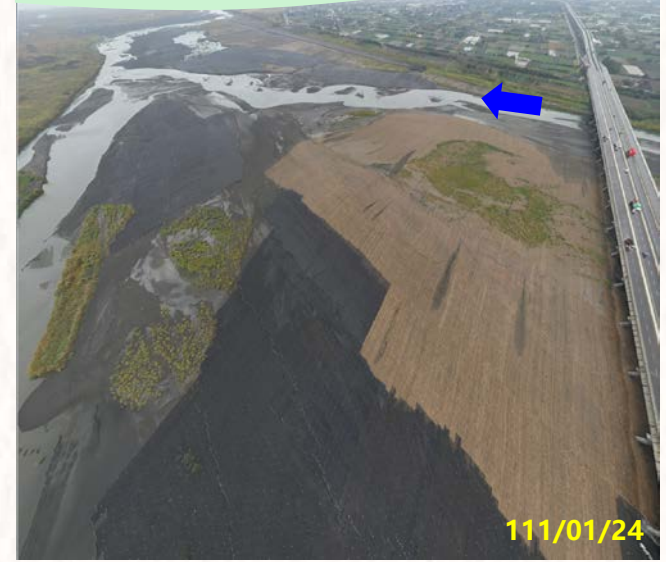
第二區 西濱大橋下游
