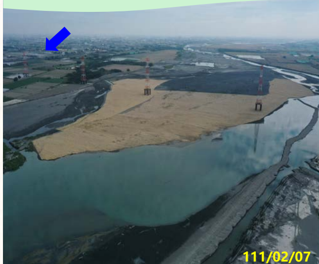
跨河鐵塔下游
