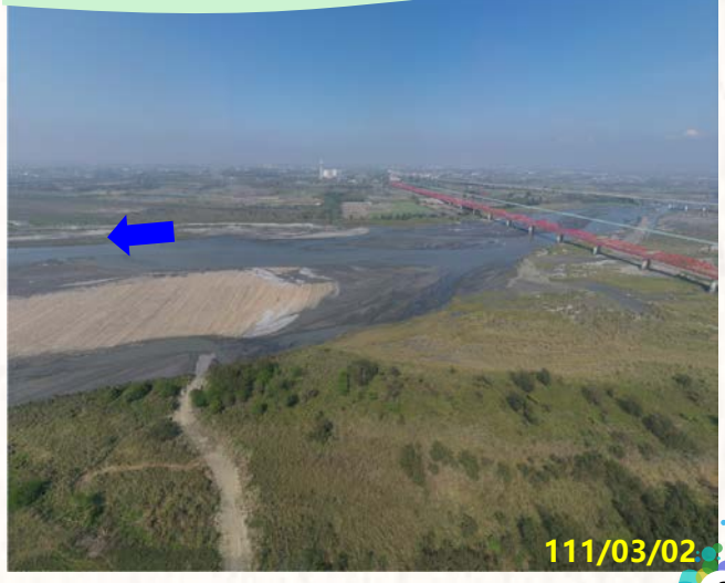
第五區 西螺大橋下游
