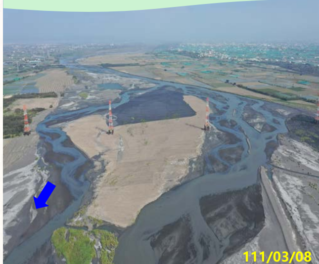
跨河鐵塔下游
