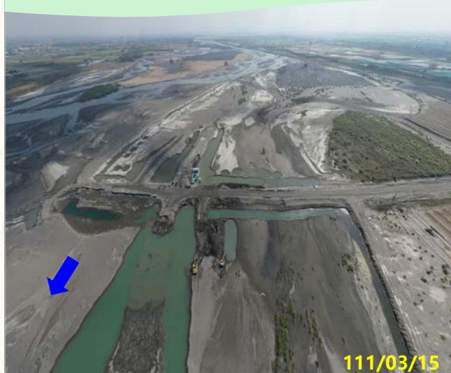
跨河鐵塔下游
