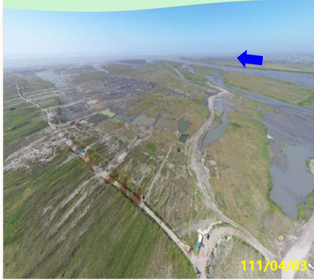
出海口 疏濬工程
