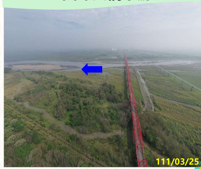
第五區 西螺大橋下游
