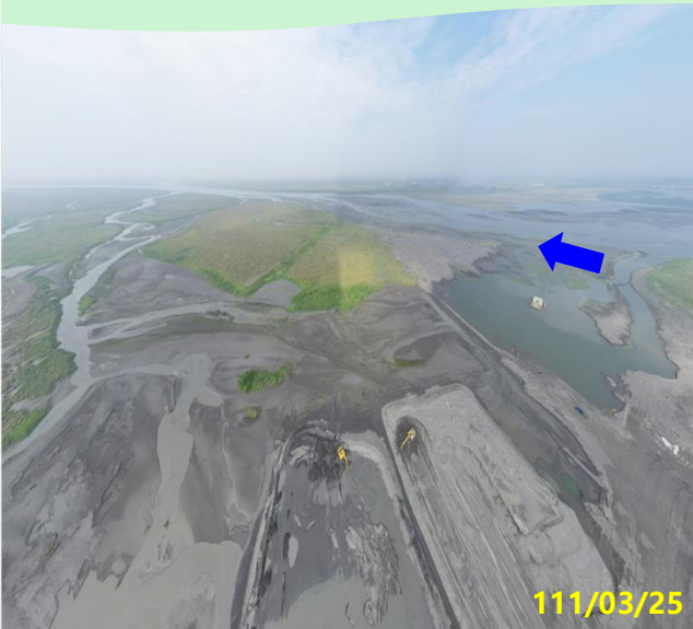
第一區 出海口 疏濬工程
