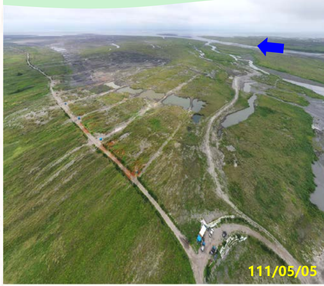
第一區 出海口 0號井
