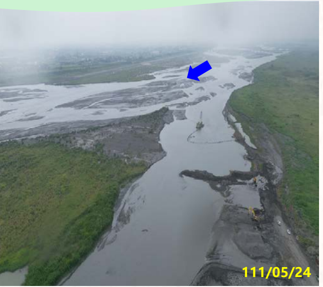
第一區 西濱大橋下游
