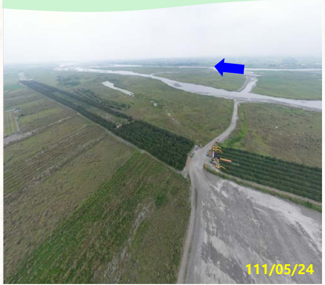
第二區 40號越堤路下游
