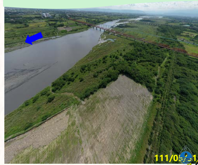
第五區 西螺大橋上下游
