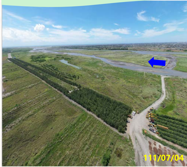
大庄堤防(40號越堤路)下游
