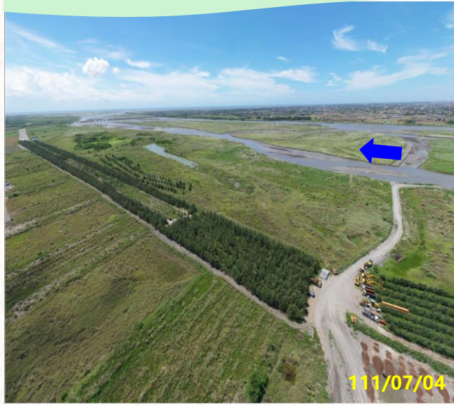
大庄堤防(40號越堤路)下游
