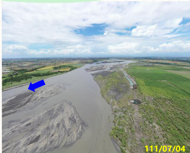
楊賢堤防(74號越堤路)下游
