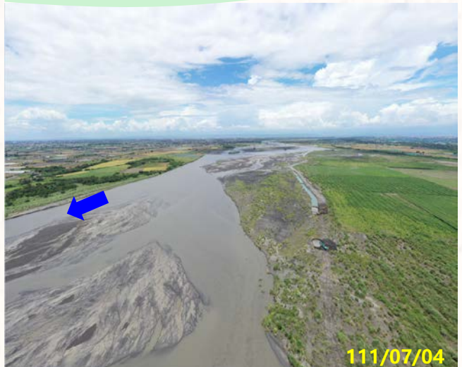
楊賢堤防(74號越堤路)下游
