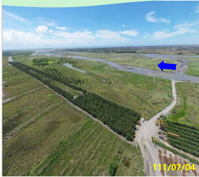
大庄堤防(40號越堤路)下游
