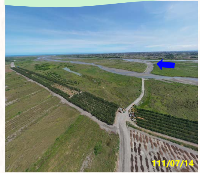
第二區 大庄堤防(40號越堤路)下游
