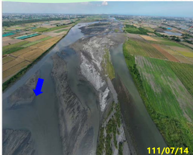
楊賢堤防(74號越堤路)下游
