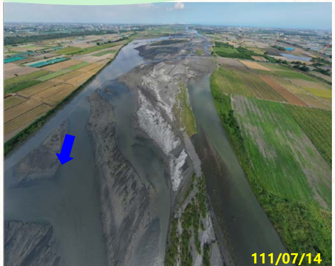
楊賢堤防(74號越堤路)下游
