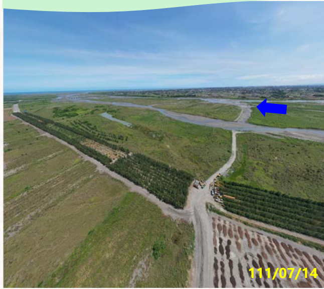
大庄堤防(40號越堤路)下游
