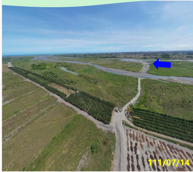
大庄堤防(40號越堤路)下游
