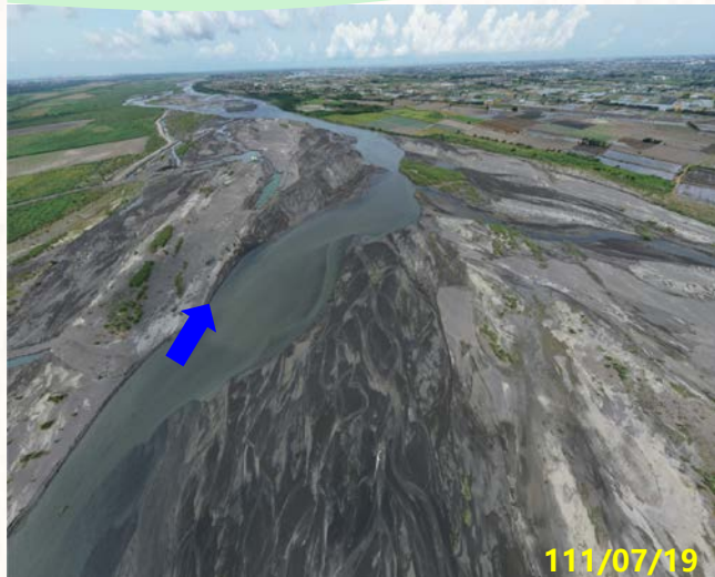
楊賢堤防(74號越堤路)下游
