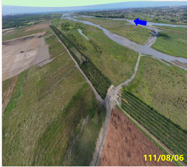
大庄堤防(40號越堤路)下游
