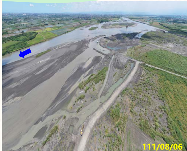
楊賢堤防(74號越堤路)上下游
