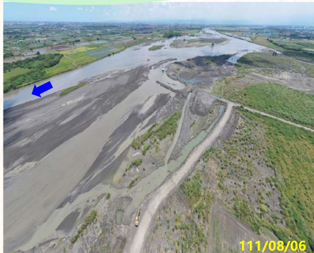
楊賢堤防(74號越堤路)上下游
