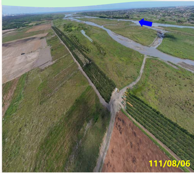
大庄堤防(40號越堤路)下游
