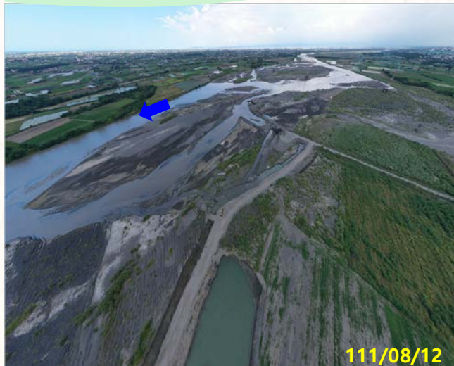
楊賢堤防(74號越堤路)上下游
