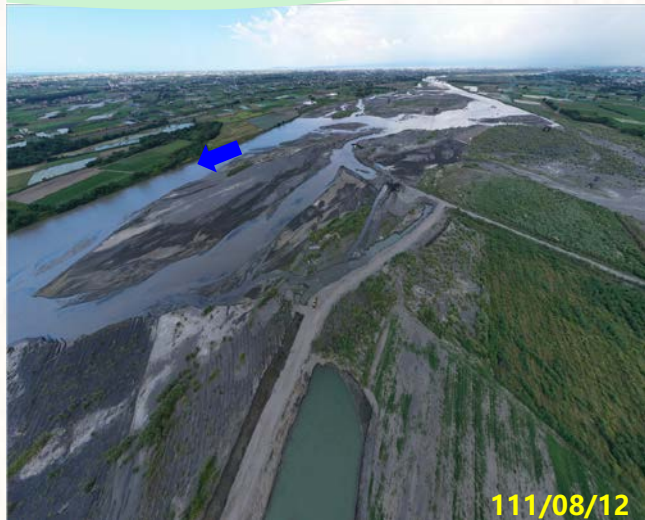
楊賢堤防(74號越堤路)上下游
