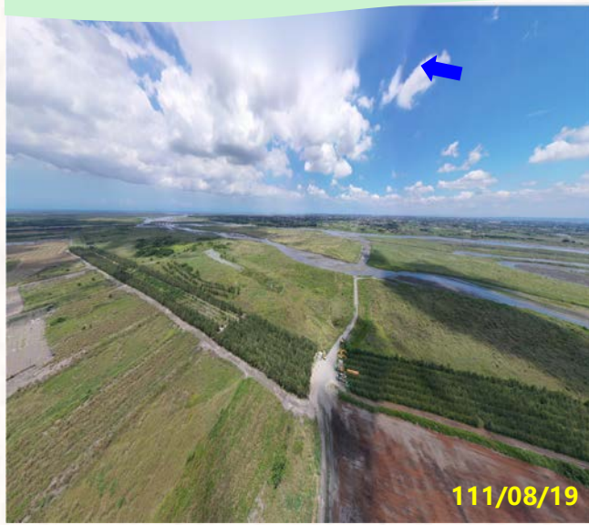
大庄堤防(40號越堤路)下游
