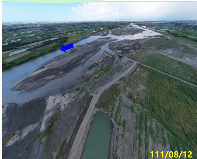
楊賢堤防(74號越堤路)上下游
