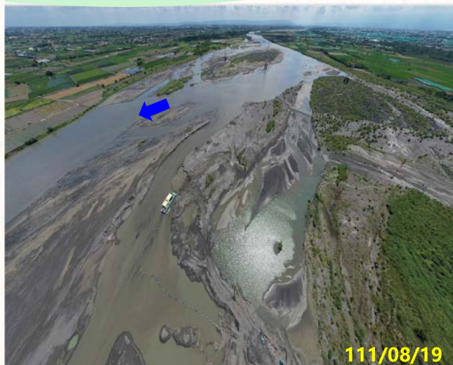
楊賢堤防(74號越堤路)上下游
