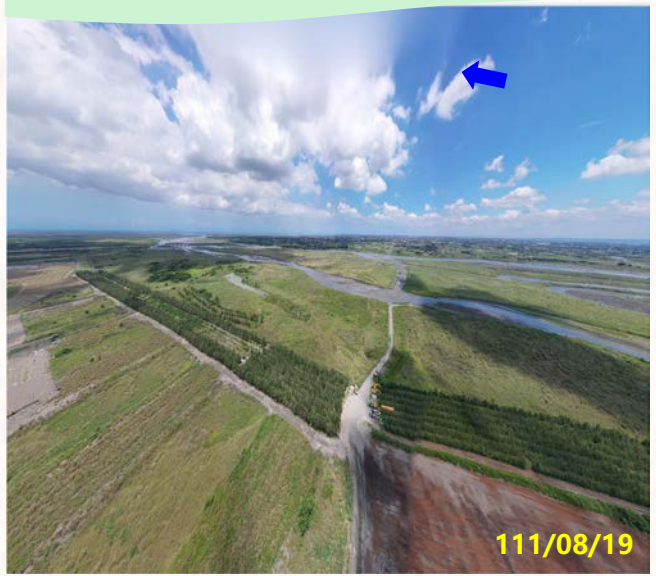
第二區 大庄堤防(40號越堤路)下游
