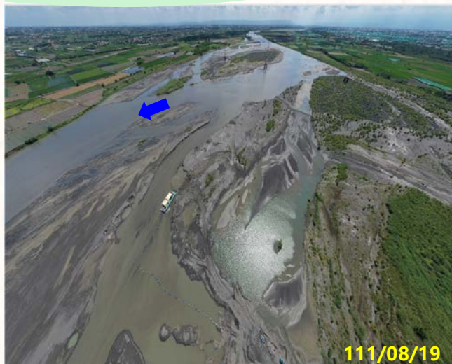
楊賢堤防(74號越堤路)上下游
