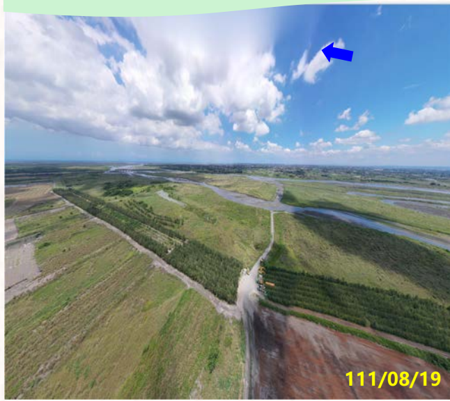
大庄堤防(40號越堤路)下游
