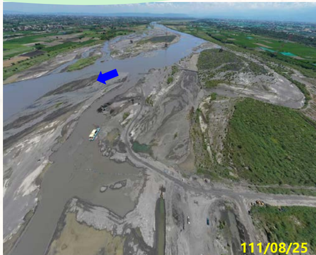
楊賢堤防(74號越堤路)上下游
