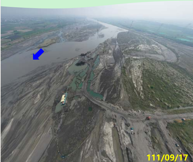
楊賢堤防(74號越堤路)上游
