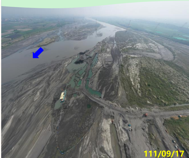
楊賢堤防(74號越堤路)上游
