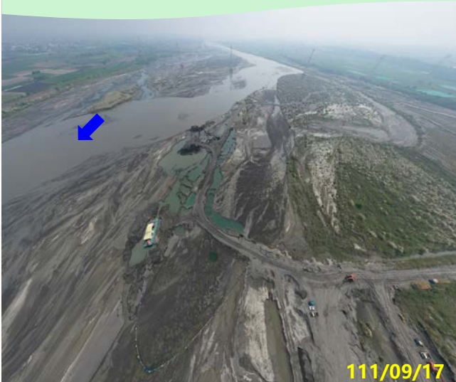
楊賢堤防(74號越堤路)上游
