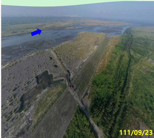
第一區 下海墘堤防(74號越堤路)上下游
