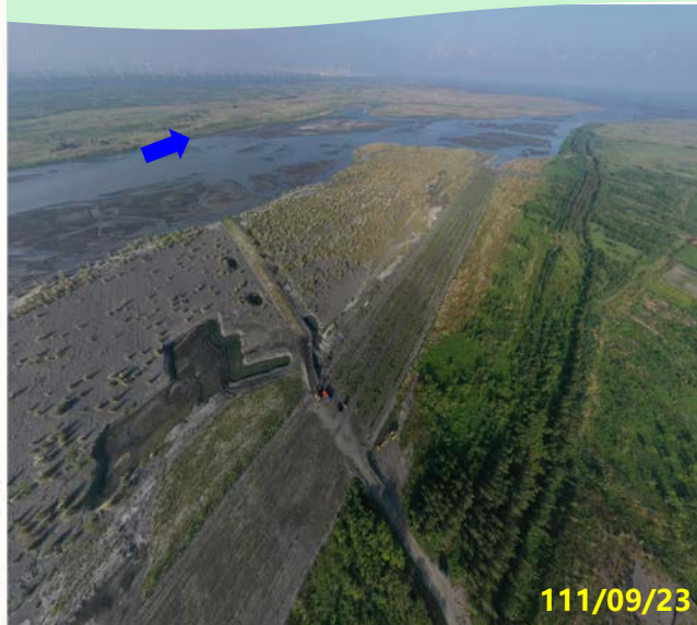
第一區 下海墘堤防(74號越堤路)上下游
