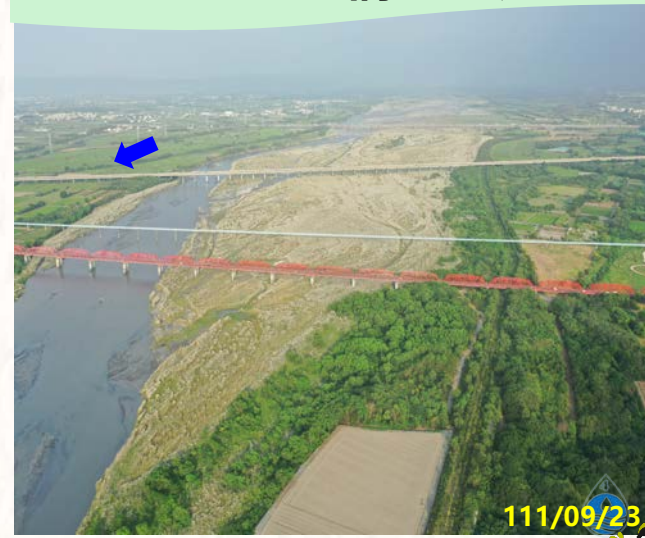
第五區 西螺大橋上下游
