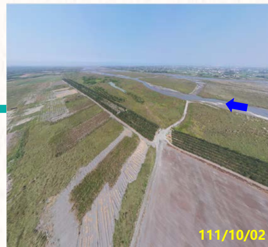
第二區 大庄堤防(40號越堤路)下游
