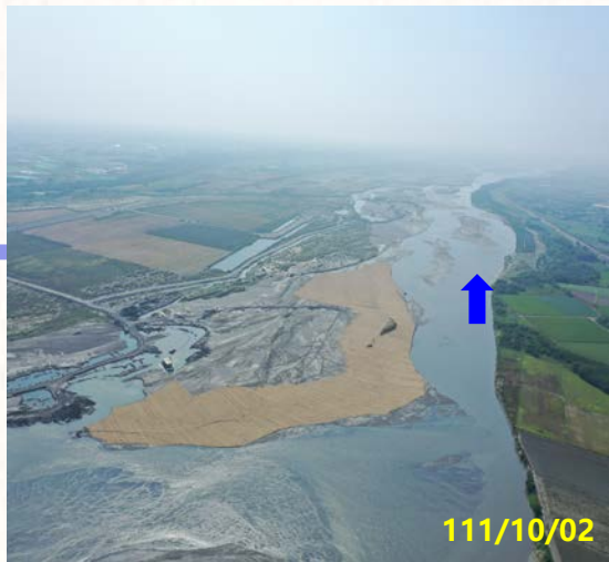
第三區 楊賢堤防(74號越堤路)下游
