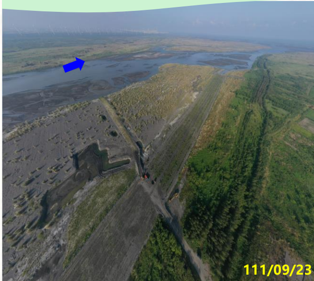
第一區 下海墘堤防(7號越堤路)上下游
