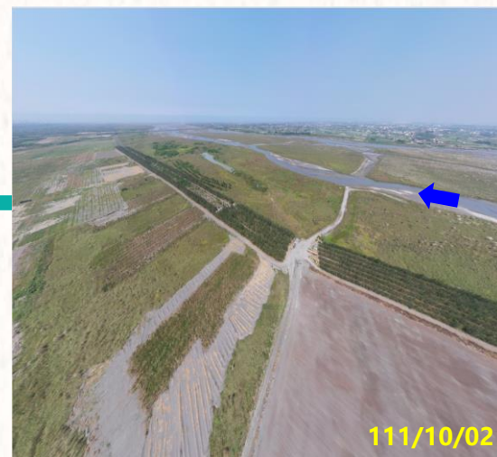
第二區 大庄堤防(40號越堤路)下游
