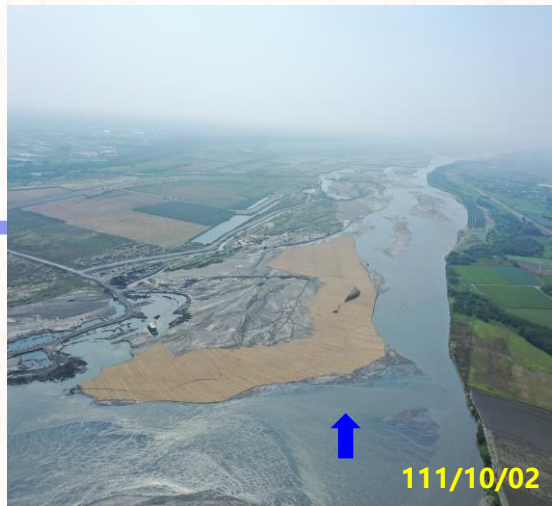
第三區 楊賢堤防(74號越堤路)下游
