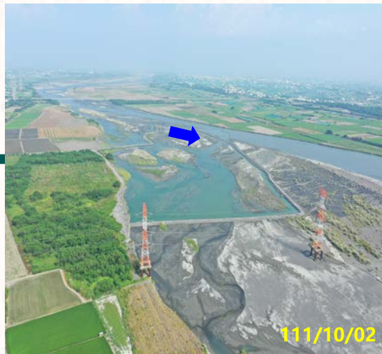
第四區 跨河電塔上游
