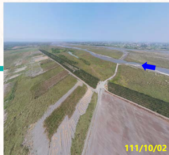
第二區 大庄堤防(40號越堤路)下游
