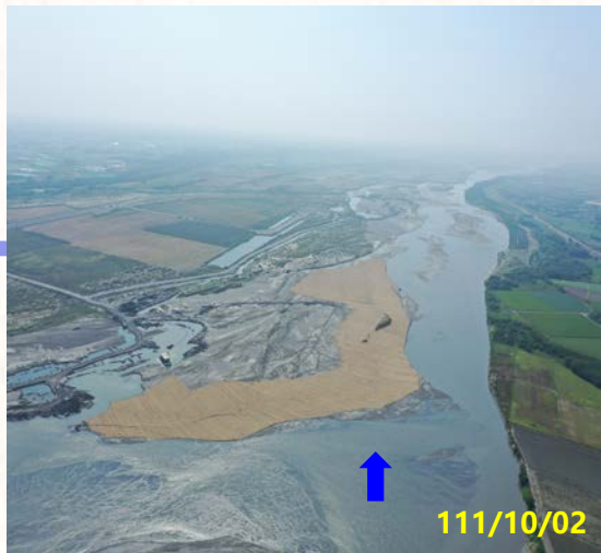
第三區 楊賢堤防(74號越堤路)下游
