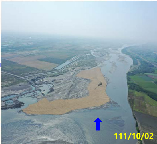
第三區 楊賢堤防(74號越堤路)下游
