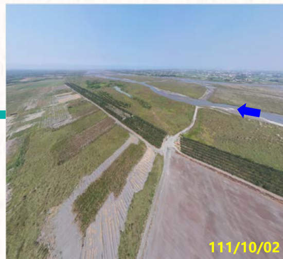
第二區 大庄堤防(40號越堤路)下游
