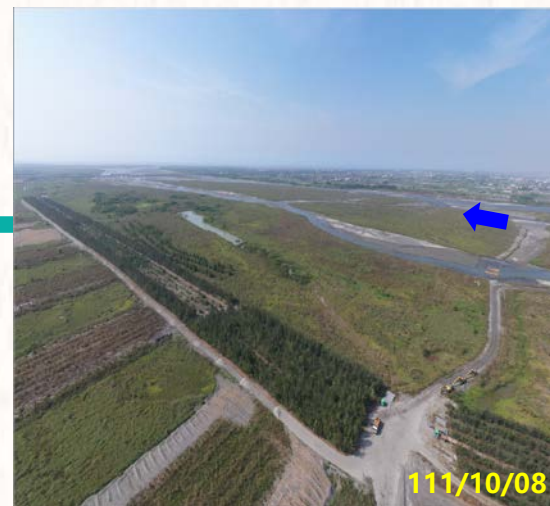
第二區 大庄堤防(40號越堤路)下游
