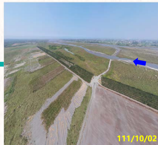
第二區 大庄堤防(40號越堤路)下游
