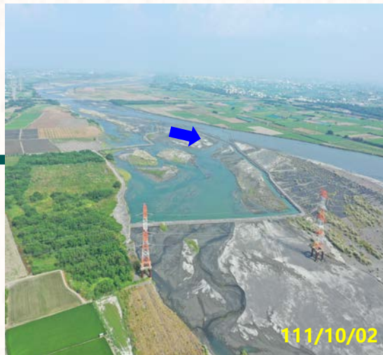
第四區 跨河電塔上游
