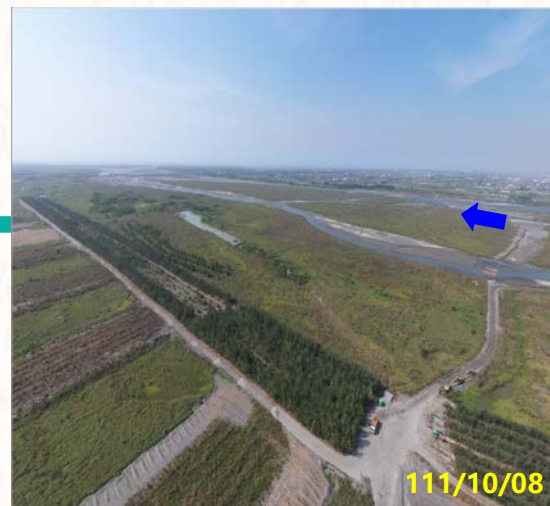
第二區 大庄堤防(40號越堤路)下游
