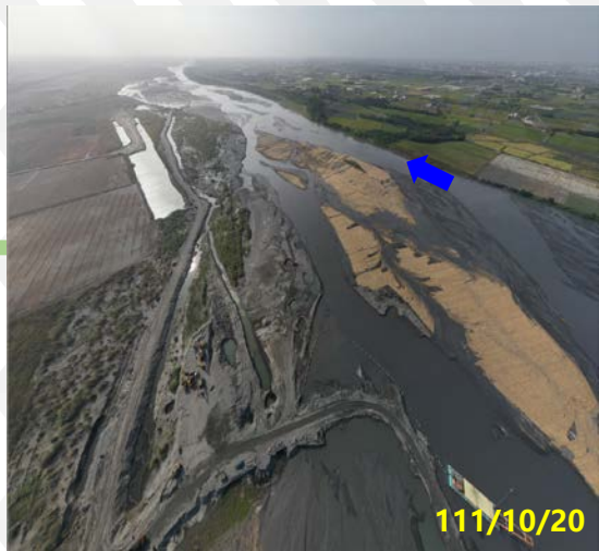
第三區 楊賢堤防(74號越堤段)下游
