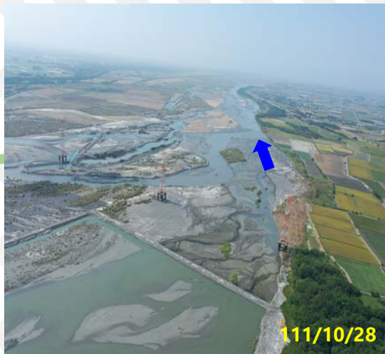
第三區 跨河電塔上下游
