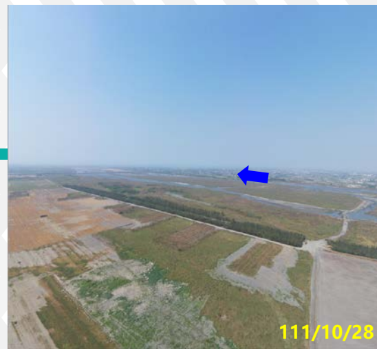
第二區 大庄堤防(40號越堤段)下游
