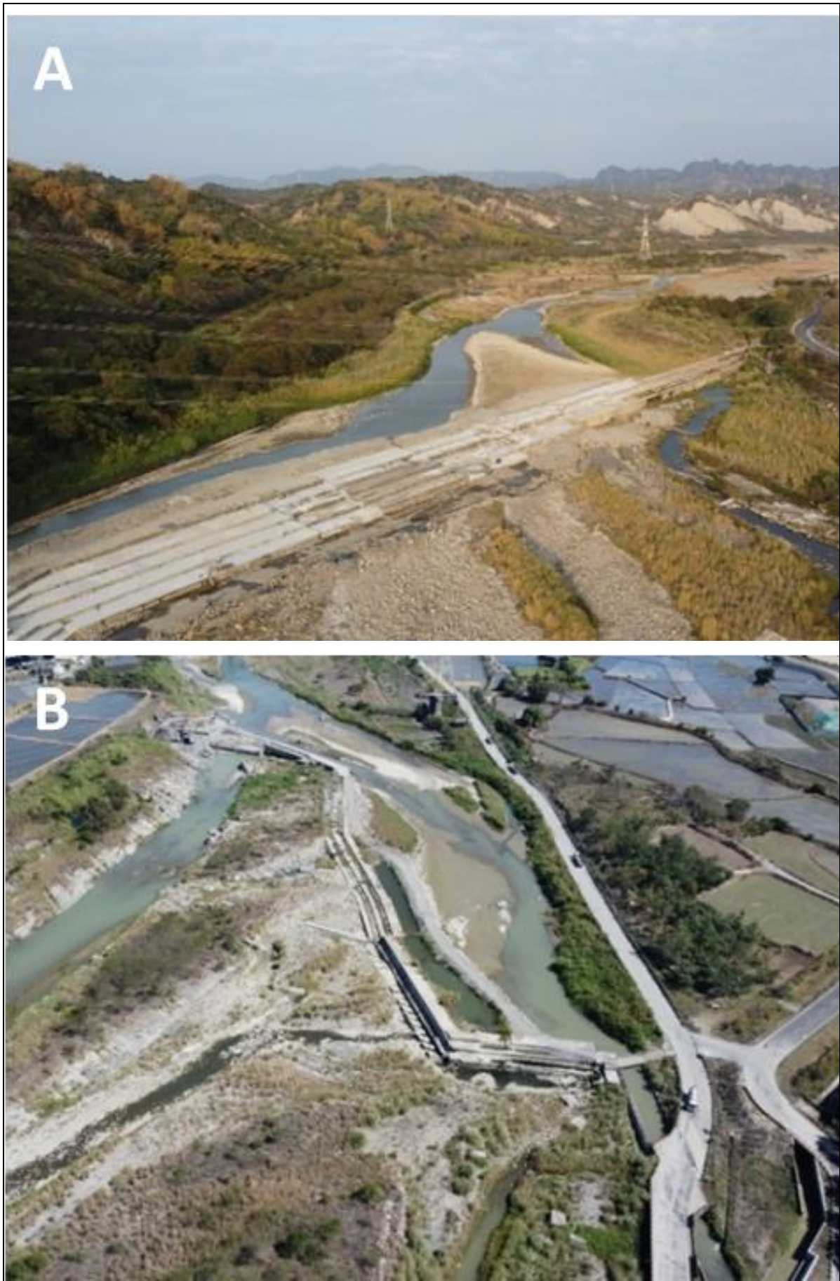
圖 2-9、烏溪阿罩霧第一圳（A）與茄荖媽助圳（B）枯水期的狀況。枯水期期間兩堰體總高超過 8 公尺，使得魚類縱向移動的機會大幅降低。
