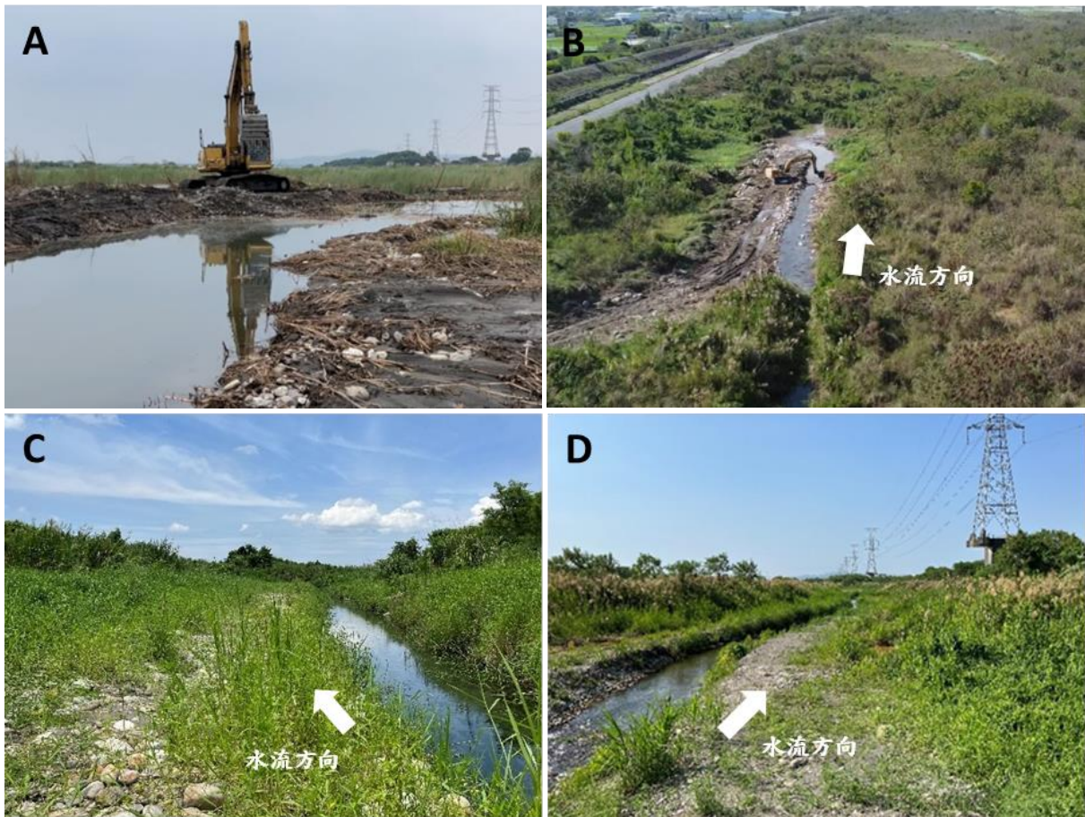
圖 3-7、棲地復原區河道與開挖過程。棲地復原區開挖工期以右岸（A、D）1 公里來說，工程約 20 天，而左岸（B、C）100 公尺則為 1 天。
