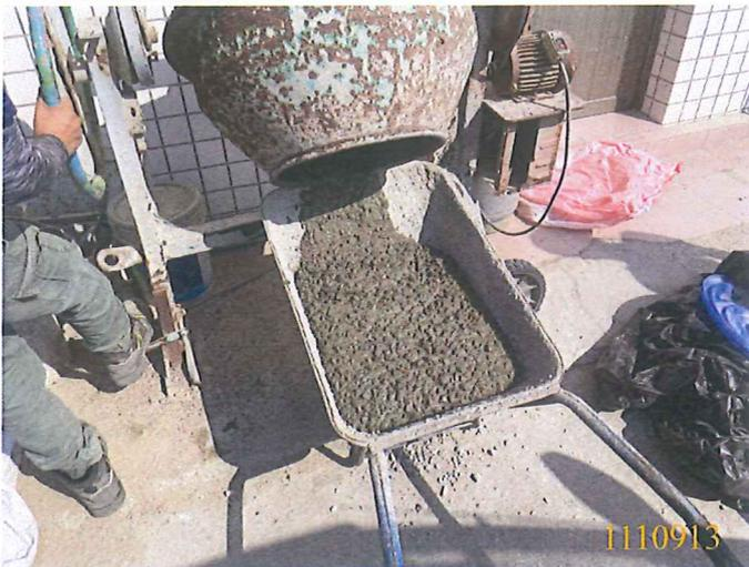
280kgfcm<sup>2</sup>(II)混凝土人工試拌
