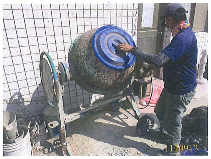
280kgfcm<sup>2</sup>(II)混凝土人工試拌
