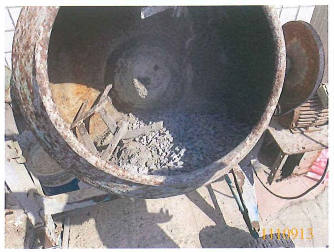
280kgfcm<sup>2</sup>(II)混凝土人工試拌
